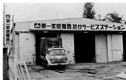
越谷サービスステーション
